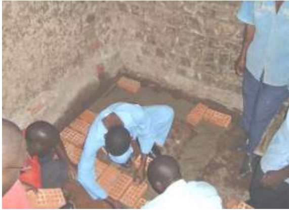
Fig. 3 - Construção da fundação
