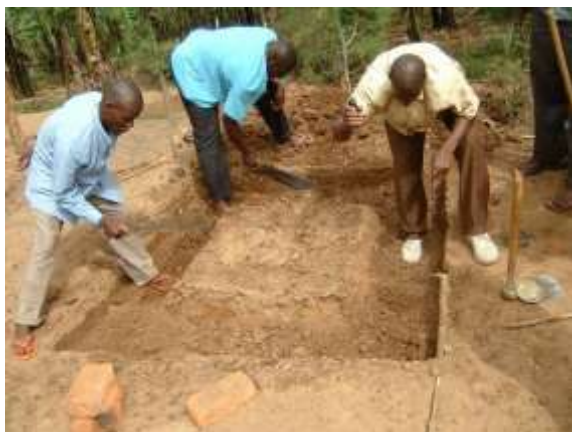
Fig. 2 - Escavação da fundação
