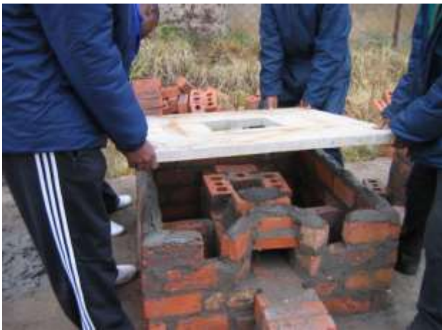
Fig. 8 - Colocação da base de laje.
