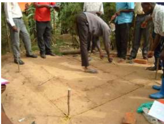
Fig. 1 - Marcação para a fundação
