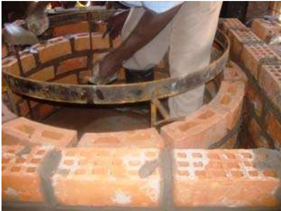
- Isolamento da Base tribaidosa
